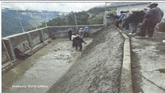
Foto 2: Reparación de cuneta de concreto
