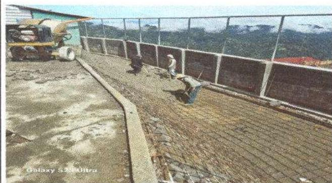
Foto 3: Reparación de banqueta de concreto
